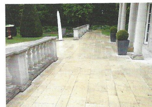
... haben Natursteinbeläge im Außenbereich einer Villa gereinigt. Fotos: Finalit
